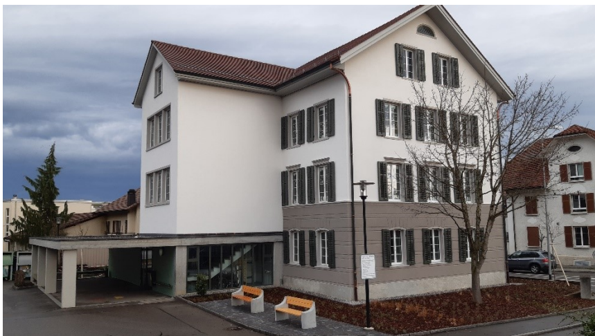
Schulhaus 1, erstrahlt nach der Aussenrenovation in neuem Glanz
